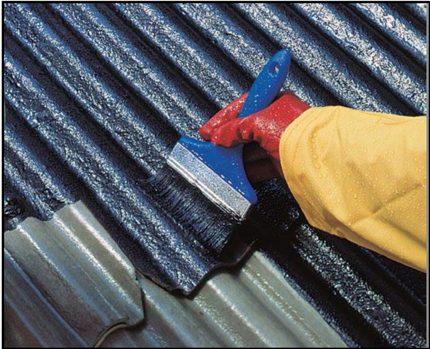
Une solution unique à base d'un mélange de caoutchouc, de bitume polymère et de fibres renforcées qui répare et imperméabilise immédiatement votre toiture.
