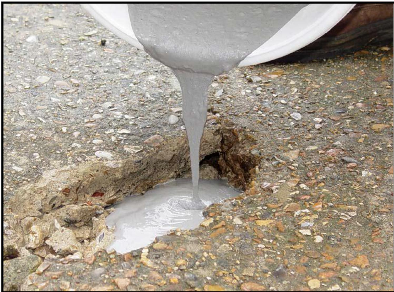
Watco Flowpatch est un produit prêt à gâcher pour reboucher les trous et les fissures sur les sols en béton, à l'intérieur comme à l'extérieur. Il donne une réparation très solide qui peut supporter une circulation piétonnière après 30 minutes ou de chariots élévateurs après 2 heures environ.
